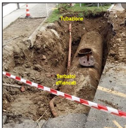
Scavo e scoperta serbatoio
